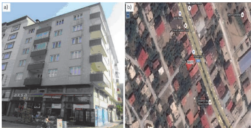
Slika 5. a) Fotografija zgrade od armiranog betona; b) Položaj ispitivanja zgrade [63]
